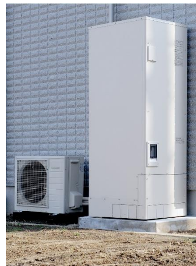
エコキュート 室外機がある。 エアコンと同じ 「ヒートポンプ」で、 外気の熱を活用し お湯を沸かす。
