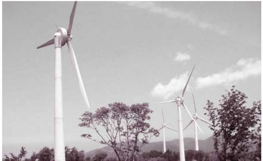
写真：京都府企業局が伊根町に建設した太鼓山風力発電所。750kWの風車が6基建てられている。
