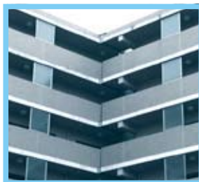
共用部廊下の照明
