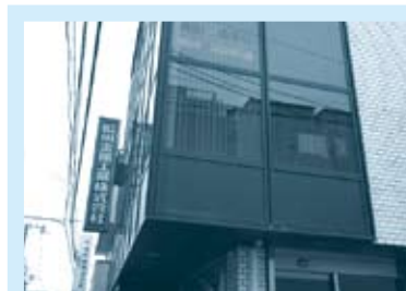
遮熱対策を実施した窓
