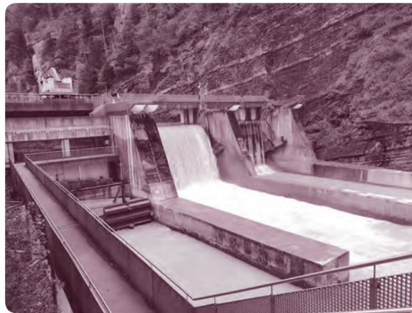
シュタットベルケ・フェルトキルヒの水力発電所
