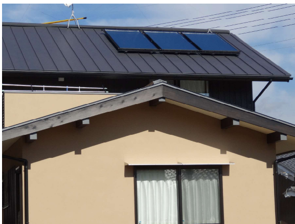
写真：ソーラーシステムの集熱板
