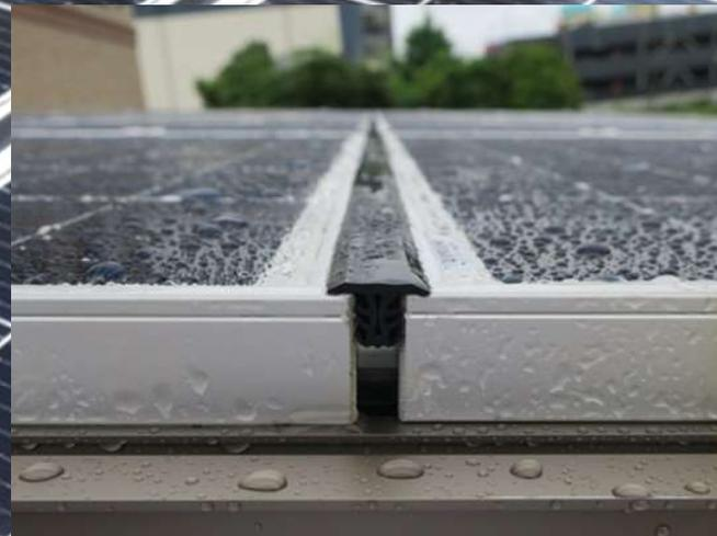
雨水止水：EPDM製
