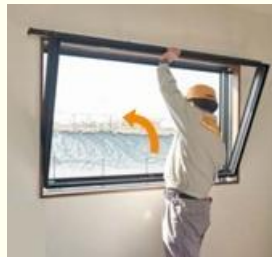
② 新しい窓枠取り付け
