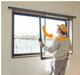
① 今の窓を取り外す （窓枠は外しません）
